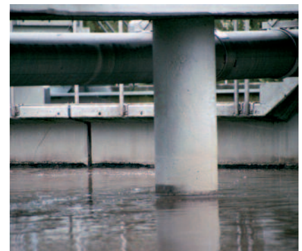
Sicheres Schließen von horizontalen und vertikalen Anschluss- und Bewegungsfugen in einer Kläranlage mit PCI Escutan TF.
