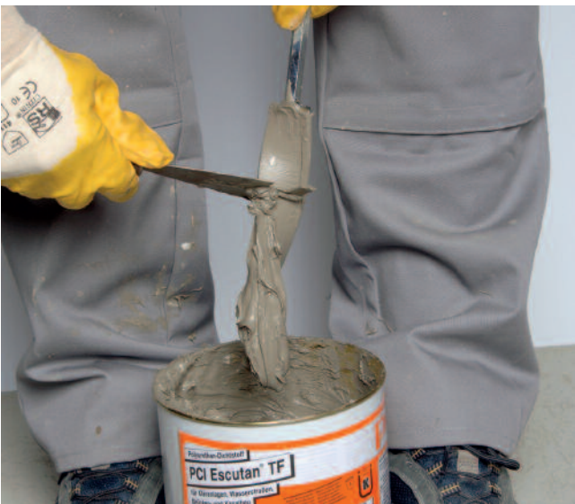
Vorreinigen des Rührwerkzeugs.
