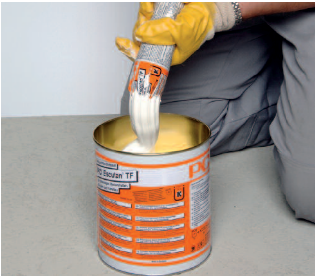
Zugeben des Härters zur Basis-Komponente.
