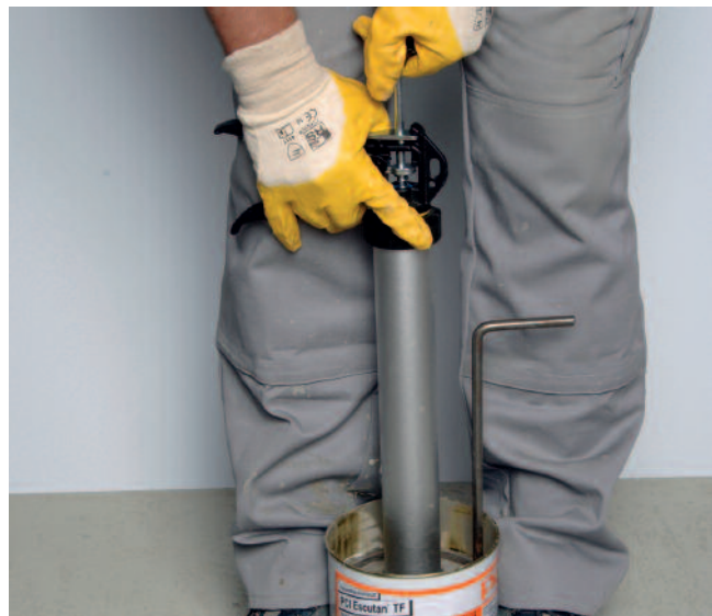
Abfüllen von PCI Escutan TF in eine Spritze mittels Saugplatte.
