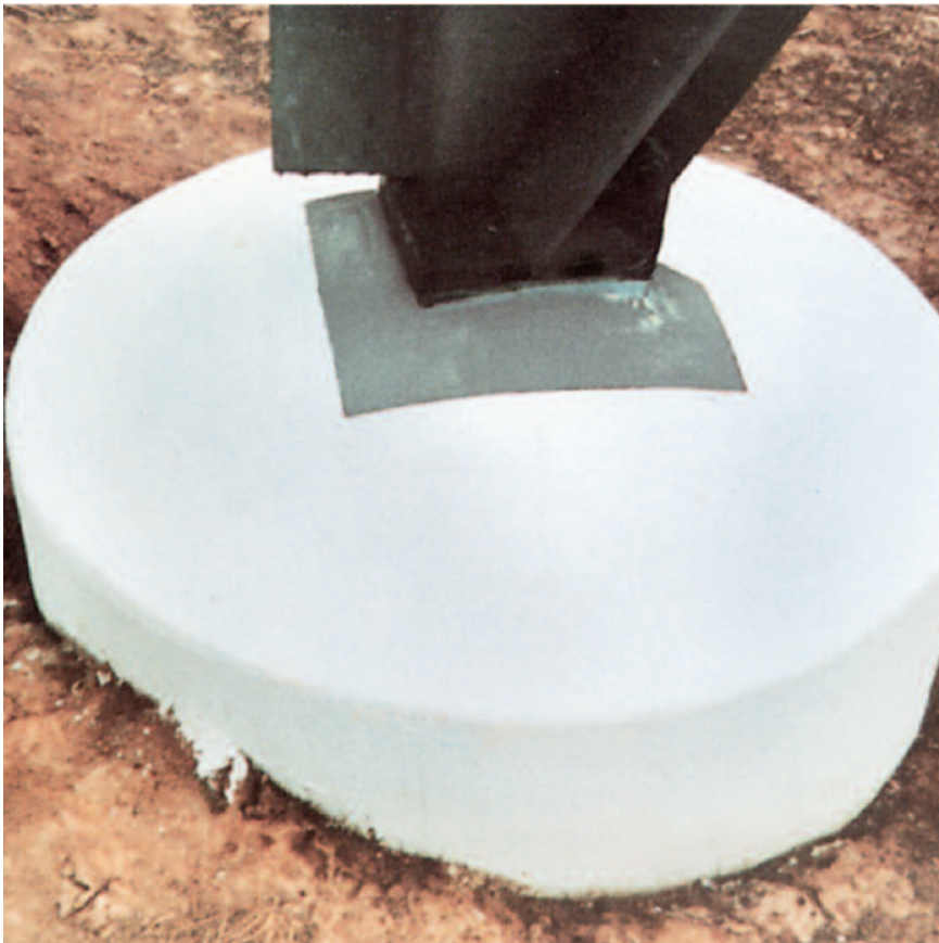
Die elastische Manschette aus PCI Escutan TF verhindert das Eindringen von Wasser in das Betonfundament eines Freileitungsmasten im Bereich des Eckstieles.
