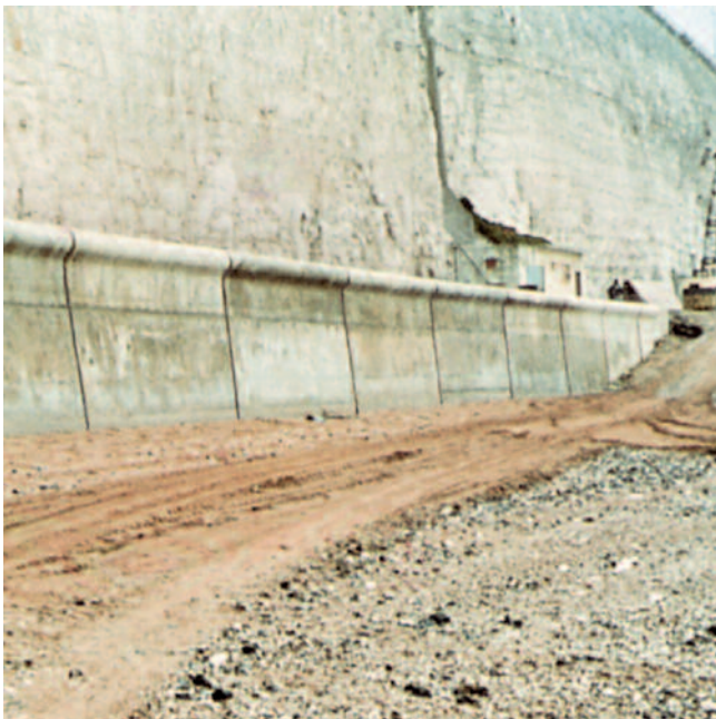
PCI Escutan TF zum Schließen der Fuge in einer Flutmauer.
