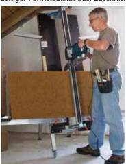
Verarbeitung kopfüber sicheren Halt in den Gefachen. Die Zugabe um eine gute Klemmwirkung zu erzielen ist mit ca. 10 mm anzunehmen. Dies ist auch in Gefachlängsrichtung pro Plattenlänge anzuwenden. Der Zuschnitt erfolgt einfach und unkompliziert mit dem STEICO Dämmstoffmesser, mit einer Stichsäge oder einem elektrischen Fuchsschwanz (jeweils mit Wellenschliffmessern). Ausführliche Informationen zur Schneidetechnik finden Sie unter:
