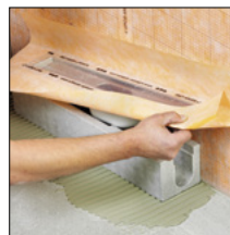
zu 2. Rinnenkörper einsetzen
