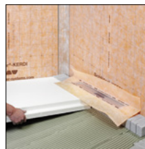
zu 3. Ausgleichsboard ebenflächig verlegen
