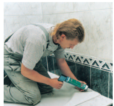
Eck-, Anschluss- und Bewegungsfugen elastisch schließen.
