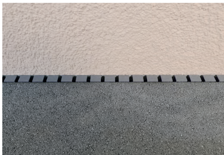
Gesicherter Feuchtigkeitstransfer entlang der Fassade.
