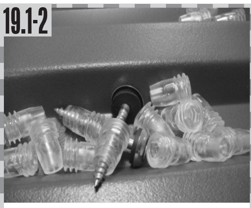
Abstandshalter und Schrauben auf der Bedachungsplatte ablegen
