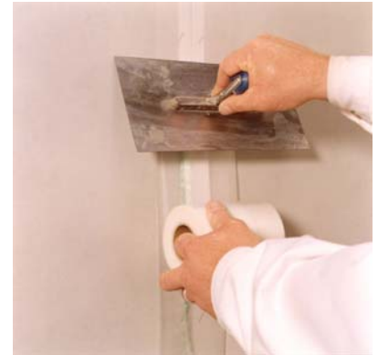
Aufbringen des FERMACELL Armierungsbandes HD
