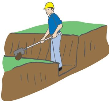
Unter dem Fundament ist eine mindestens 10 – 15 cm dicke Filterschicht aus verdichtetem Kies oder Lava anzulegen.
