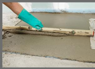
PCI Novoment<sup>®</sup> Light erlaubt Schichtdicken von 20 bis 80 mm und ist feuchtigkeitsunempfindlich – ideal für den Einsatz in Dauernassbereichen und im Gefälle.
