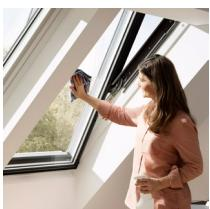
Um die äußere Scheibe von innen zu reinigen, drehen Sie den Flügel von Hand und sichern ihn mit dem Putzriegel in der Reinigungsposition.
