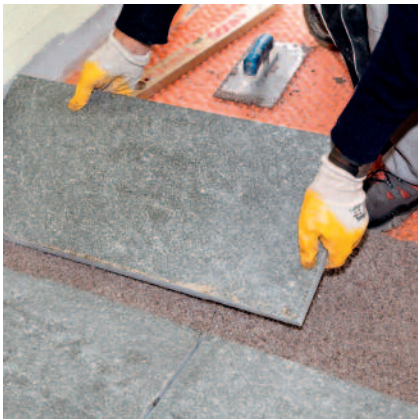
Natursteinplatte in das vorgezogene Mörtelbett einklopfen.
