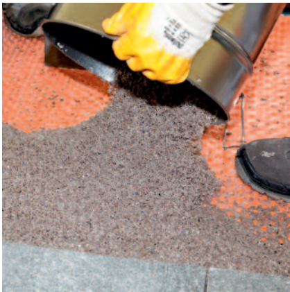
25 kg Quarzsand mit 1 kg Epoxigrund Rapid homogen vermischt.
