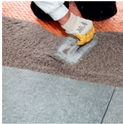
Gleichmäßig mit einer Mindestschichtdicke von mind. 20 mm verteilen.
