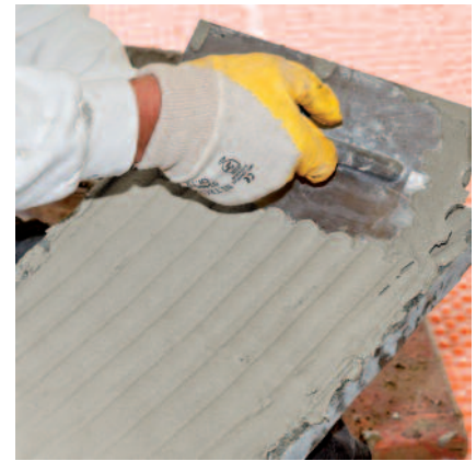
Haftbrücke aus PCI Carrafloft NT auftragen.
