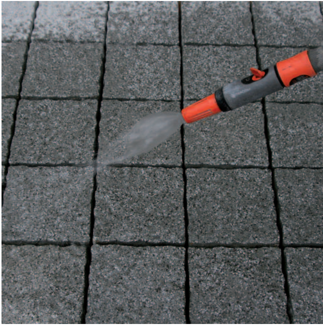
Steinoberfläche und Fugenflanken vor der Verfugung kräftig vornässen.
