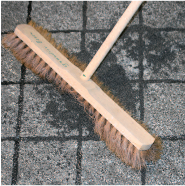
Mörtelreste mit einem weichen Besen vollständig von der Belagsoberfläche entfernen.
