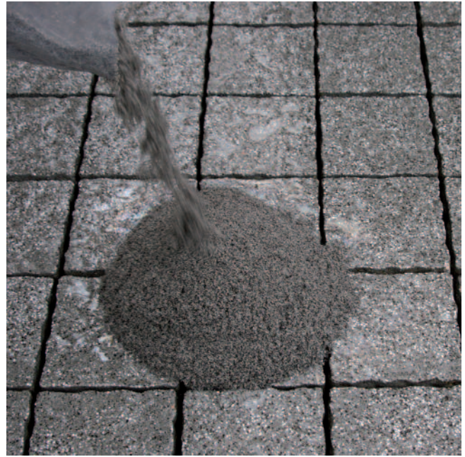
Vakuumbbeutel aufschneiden und frisches Material auf die nasse Belags- oberfläche schütten.
