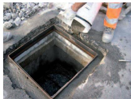
Ausgießen eines Kanalschachtrahmens mit PCI Repafast Fluid.
