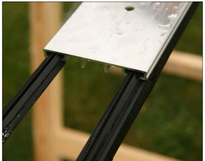
Dichtgummi in die Aluprofile einziehen.
