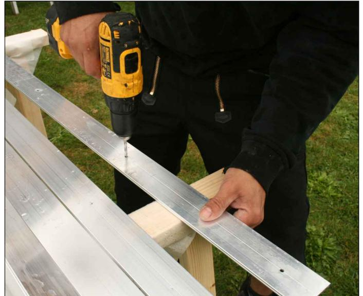
Dichtgummi in die Aluprofile einziehen und die Aluprofile mit einem 5mm Metallbohrer in einem gleichmäßigen Abstand vorbohren. Teilen Sie die Anzahl der Schrauben (siehe Positionsplan) durch die der Sparren um die Gesamtzahl der zu verteilenden Schrauben pro Aluprofil zu erhalten.
