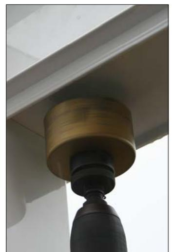
Mit einer Bohrkronen (Durchmesser 68-70mm) bohren Sie jetzt den Anschluß für das Fallrohr. Es kann sowohl neben als auch im Pfosten verbaut werden. **Bitte beachten Sie dabei den Versatz in der Rinnenpfette (siehe Detailzeichnung) sowie den Abstand der Cliphalter für das Fallrohr zum Pfosten ! (ca. 2cm)**
