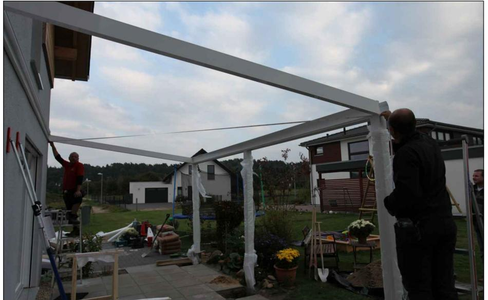
Richten Sie die Konstruktion mit einem Maßband über die Diagonale aus.
