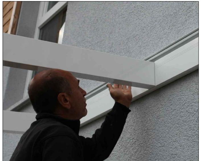
Verteilen Sie die anderen Sparren mit Hilfe der Blendleisten (dienen als Abstandshalter), bohren Sie die Schraublöcher mit einem 4mm Metallbohrer vor und verschrauben Sie die Sparren mit jeweils einer Karosserieschraube (C101-025) an den beiden Pfetten.
