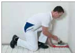
Die Randplatten können mit Hilfe eines TE-Zugeisens leicht eingesetzt werden. Nach Abschluss der Arbeiten müssen evtl. gesetzte Keile entfernt werden. Zur Vorbereitung auf die folgenden Arbeitsschritte muss die Fläche staubfrei und frei
