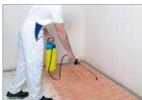
Die rötliche Grundierung wird mit einem Drucksprüher gleichmäßig aufgebracht. Um auch die Flanken der Ausfräsungen vollständig zu grundieren, wird das kreuzweise Sprühen aus mehreren Richtungen empfohlen. Die NORIT-Grundierung
