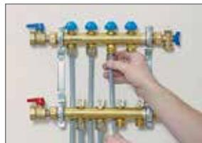
Das Anschließen der Rohre und die Dichtheitsprüfung durch die Wasserdruckprobe (nach DIN EN 1264-4) darf nur durch nachgewiesen befähigtes Personal erfolgen. Der Prüfdruck muss 24 Stunden aufrechterhalten werden bis die
