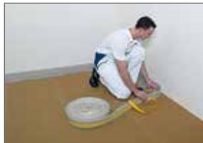
Vor der Verlegung der TE Therm-Elemente wird umlaufend der NORIT-Randdämmstreifen angebracht. Die befestigte Folie wird voll ausgebreitet in den Raum gelegt. In Ecken wird die Folie überlappt. An Kanten wird eine zusätzliche Folie zur Abdichtung angebracht. Das Abkleben von Stößen des Randdämmstreifens und der Schleppfolie ermöglicht ein sicheres Vergießen der Fläche.
