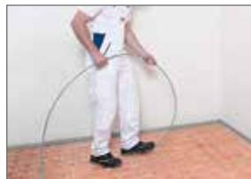
Das NORIT-Heizrohr wird nach der Vorgabe des Fachplaners verlegt. Es ist darauf zu achten, dass das Rohr sauber in die fix-Führung ein-klickt, es darf nicht verdrehen oder knicken. Die max. Heizkreislänge von 80 m kann durch die laufende
