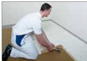
Die Elemente werden stirnseitig mittels Hammer und NORIT-TE-Verlegeklotz zusammengefügt. Direktes Schlagen mit dem Hammer auf das Klick-Profil kann zu Beschädigungen führen. Dehnungsfugen sind erst ab einer
