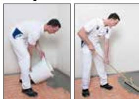
Vor dem Aufbringen der Vergussmasse muss kontrolliert werden, dass das Heizrohr richtig in der fix-Führung liegt. Zum Verfüllen der Fläche wird ein Sack Vergussmasse (25 kg) mit 6 l Wasser klumpenfrei angerührt und anschlie-
