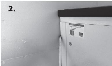
2. Außenkante des Wandanschlussprofils beidseitig auf Montageuntergrund anzeichnen. Aufstockelement vom Lichtschacht nehmen und Wandanschlussprofile vom Aufstockelement entfernen.
