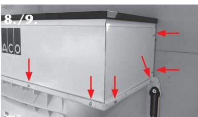
8. Aufstockelement mit Lichtschacht verschrauben. Mit 4 mm Bohrer vorbohren. Hierzu Spaxschrauben mit Spitze verwenden. Vorderseitig 4 Schrauben (Großlichtschacht 6) und seitlich je 2 Schrauben (Großlichtschacht 3) eindrehen.
