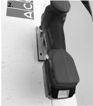
2. Aufstockelement mit einer Stichsäge ablängen. Zuvor ggf. Verstärkungseisen entfernen
