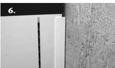
5. Das höhenverstellbare Aufstockelement über den Lichtschacht oder das fixe Aufstockelement schieben und ausrichten. Im Anschluss die Verschraubung von innen nach außen, beginnend mit den beiden hinteren Verschraubungspunkte, vornehmen.
