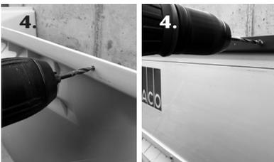
4. Mit 4 mm Bohrer Rostkante des Lichtschachtes und oder des fixen Aufstockelementes durchbohren. Bei Lichtschächten der neuen 600er Serie ist das Vorbohren nicht erforderlich. Hier können die Vorperforierungen direkt durchschraubt werden. Seitlich ca. 50 mm von Wand entfernt bleiben. Die Bohrungen in gleichmäßigen Abständen setzen.
