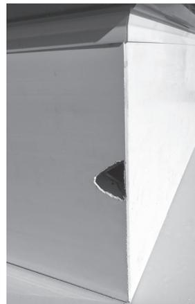
Profilkammer mit weiteren Bohrungen soweit öffnen, so dass das Verstärkungseisen entnommen werden kann
