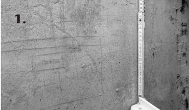
1. Lichtschacht entsprechend der Lichtschacht-Montageanleitung montieren und im Anschluss Lichtschachtrost entnehmen. Maß von Geländeoberkante bis Oberkante Lichtschacht-Rostkante ermitteln.
