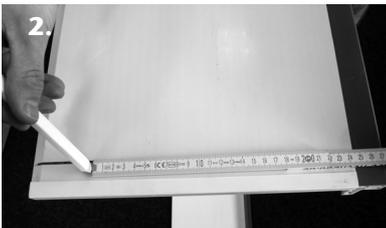
2. Ermitteltes Maß auf die Außenseite des höhenverstellbaren Aufstockelementes übertragen. Ausgehend von der Oberkante des höhenverstellbaren Aufstockelementes. (Dieser Punkt entfällt bei der Montage vom höhenverstellbaren Aufstockelement auf ein fixes Aufstockelement.)
