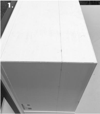
1. Benötigte Bauhöhe ermitteln und auf Aufstockelement übertragen. Die U-Profilstärke von 3 mm ist hier zu berücksichtigen
