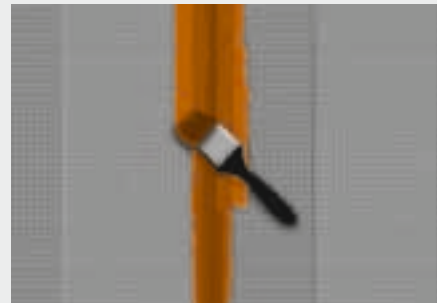
Abb. 2: fermacell Dichtband in die zuvor aufgetragene, noch feuchte fermacell Flüssigfolie drücken und direkt mit Flüssigfolie überstreichen
