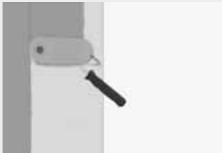
Abb. 1: Vollflächiges Aufbringen des fermacell Tiefengrunds
