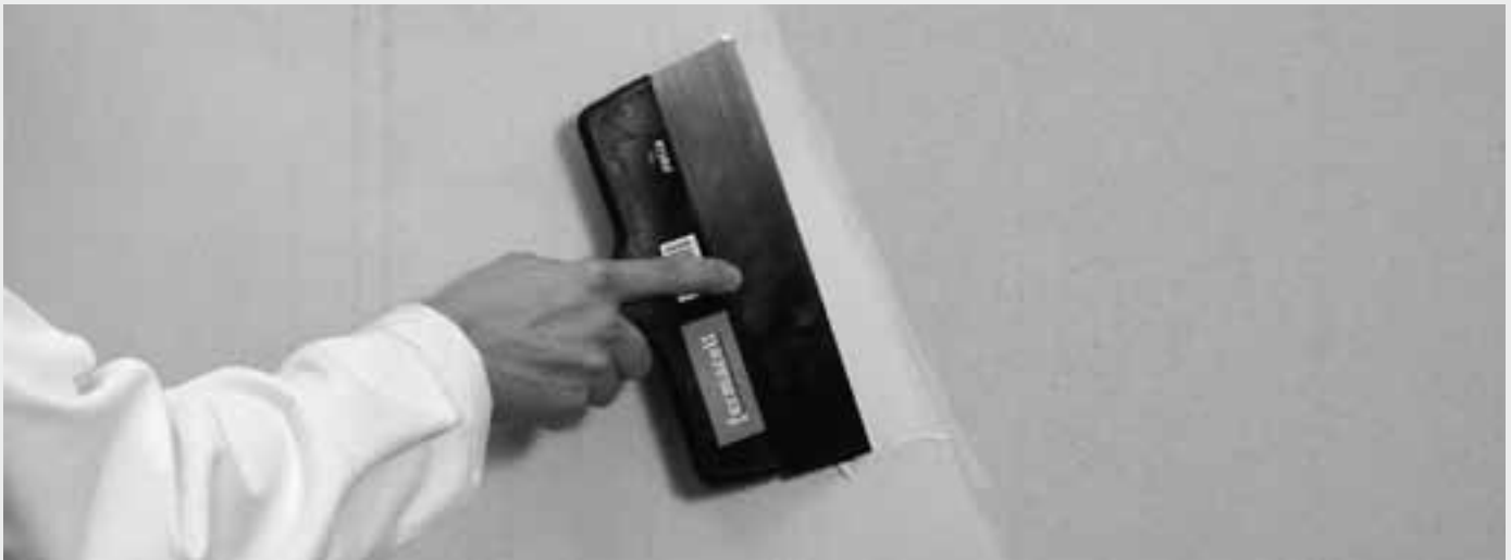
Flächenspachtelung von fermacell Gipsfaser-Platten
