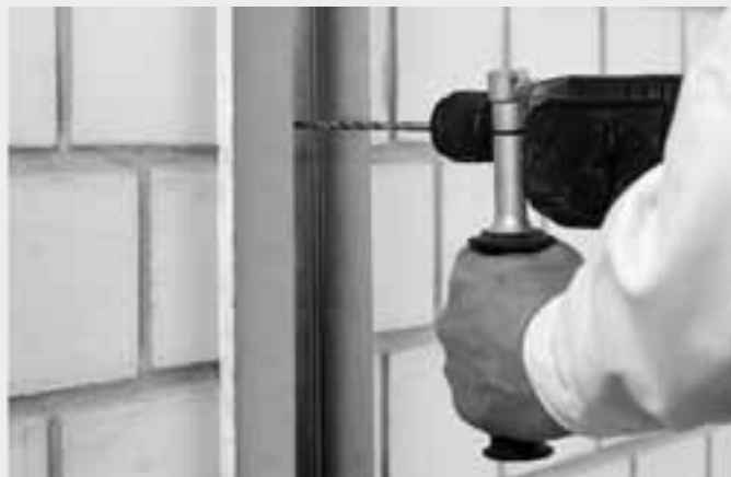
Befestigung der CW-Profile an Massivwand auf Dämmstreifen
