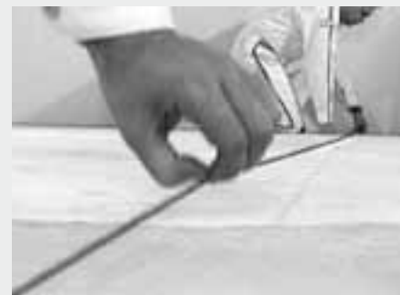
Anlegen der Wandachse mit Schnurschlag oder Hochbaulaser
