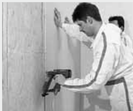
Beplankung der Holzunterkonstruktion mit Klammern
