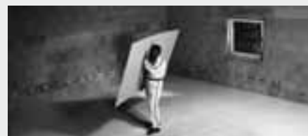
Einzelne fermacell Gipsfaser-Platten hochkant tragen
