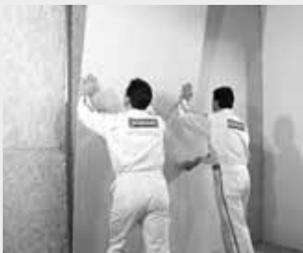
Beplankung der Metallunterkonstruktion
