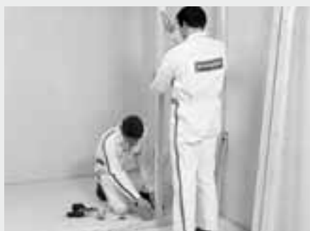
Montage der Holzständer mit Stiftnagel oder Stahlwinkel
