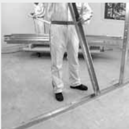
Montage der CW-Ständerprofile
