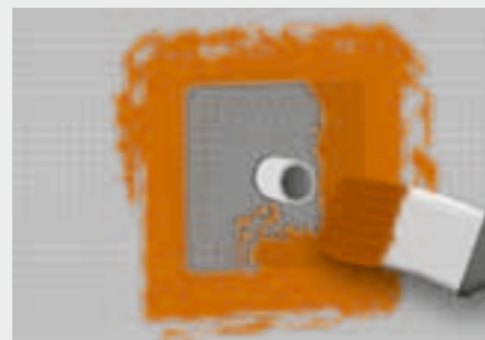
Abb. 4: Zur Abdichtung von Rohrdurchführungen die Wanddichtmanschette in die noch feuchte fermacell Flüssigfolie einbetten und direkt erneut überstreichen
