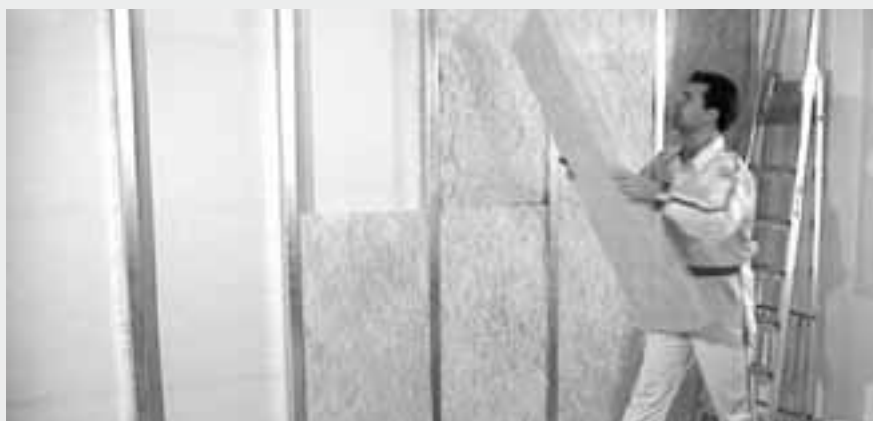
Einbringen der Dämmstoff-Platten
