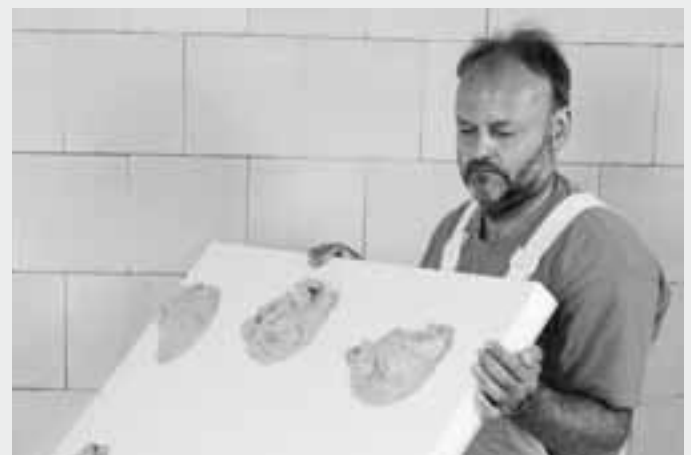
fermacell Verbund-Platte: Abmessung: 150 x 100 cm = 1,5 m 2 fermacell 10 mm plus Dämmstoff
