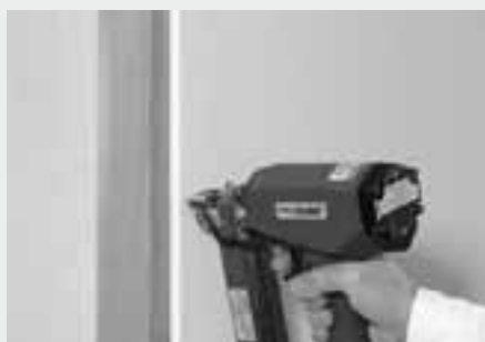
Klammern auf Holzunterkonstruktion
