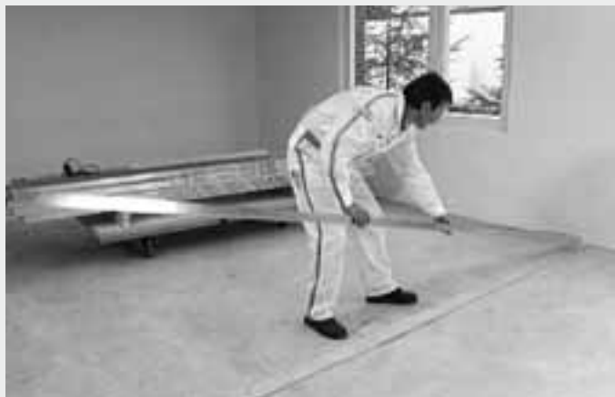
Auslegen der UW-Anschlussprofile am Boden auf Dämmstreifen
