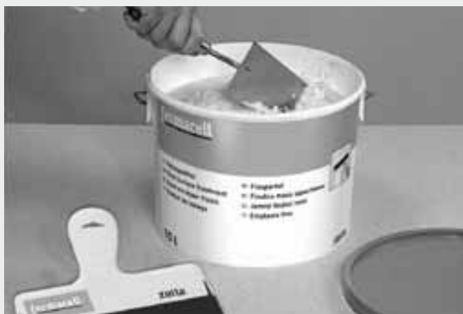
Flächenspachtelung mit fermacell Feinspachtel und mit fermacell Gips-Flächenspachtel
