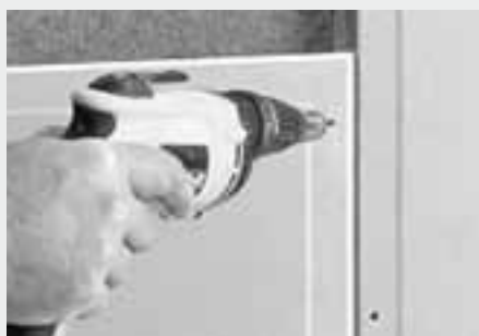
Schrauben auf Stahlunterkonstruktion
