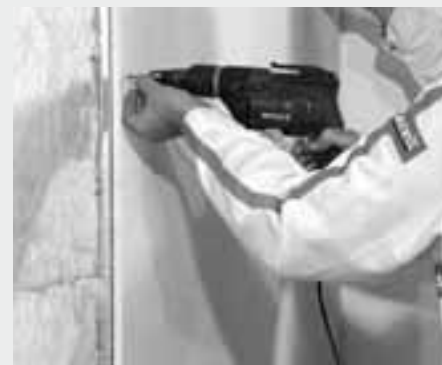
Ansetzen des Schnellbauschraubers
