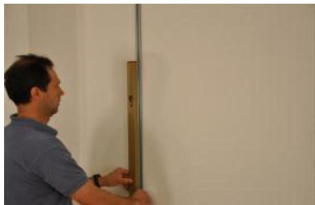
2. Bringen Sie die Schienen ins Lot und zeichnen Sie die Bohrlöcher an (ca. alle 60-70 cm ein Bohrloch vorsehen). Zum Abhängen der Befestigungsschienen verwenden Sie eine handelsübliche Metallbügelsäge.
