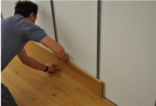
7. Nach Anbringung der Anfangsklammern werden die Dielen einfach in die Befestigungsschienen eingeklickt.
