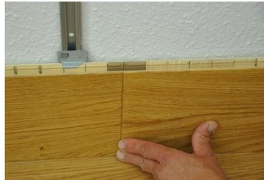
8. Montieren Sie die erste Reihe von links nach rechts und verriegeln Sie die einzelnen Elemente an den Stirnstößen.
