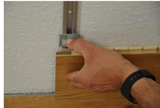
10. Befestigungsklammer nach unten auf Verbindung schieben
