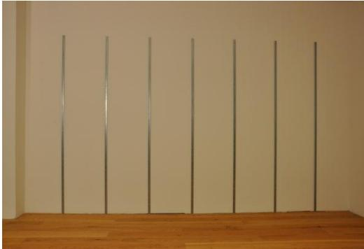
3. Bringen Sie die Schienen im Abstand von ca. 50 cm (siehe Punkt 1) mit passenden Dübeln und Schrauben an die Wand an. Leichte Unebenheiten der Wand können mit Hilfe von Distanzstücken oder Holzkeilen ausgeglichen werden.
