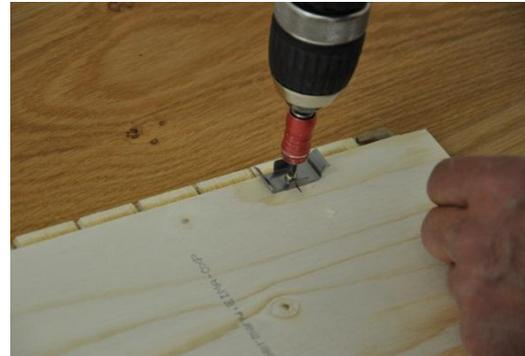
6. Zur Anbringung der Anfangs- und Endklammern (mit ca. 2 cm Außenabstand) verwenden Sie die beigefügten Schrauben. Die Schrauben fest anziehen, aber nicht überdrehen.
