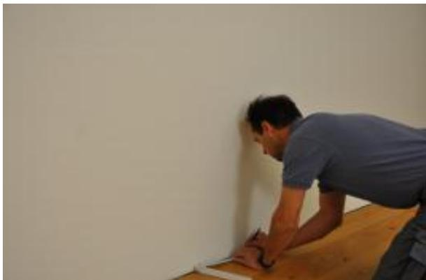
1. Je nach gewünschter Fläche der Wandverkleidung messen Sie die Abstände und die Höhe der Befestigungsschienen aus und zeichnen diese an der Wand an. (Schienenabstände bei HARO Parkett Serie 4000: ca. 50 cm)
