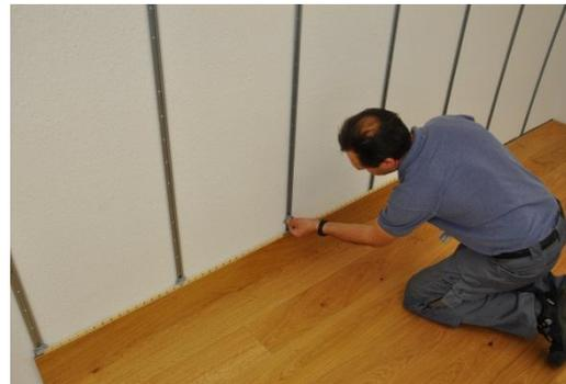
12. Bringen Sie die Befestigungsklammer auf jeder Befestigungsschiene an
