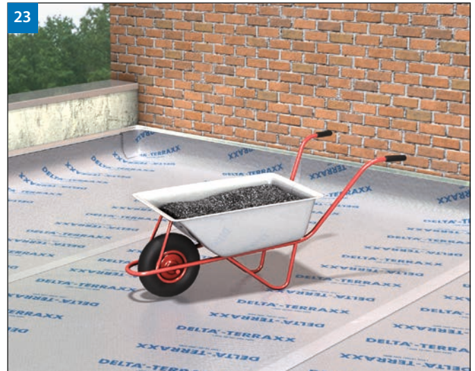
(Bild 23) Beim Einsatz auf erdüberschütteten Decken kann die verlegte Dränbahn zur Verfüllung direkt mit einer Schubkarre befahren werden. Bei vorauslaufender Schüttung von mind. 20 cm kann DELTA®-TERRAXX in der Bauphase vorsichtig mit Radlader befahren werden.
