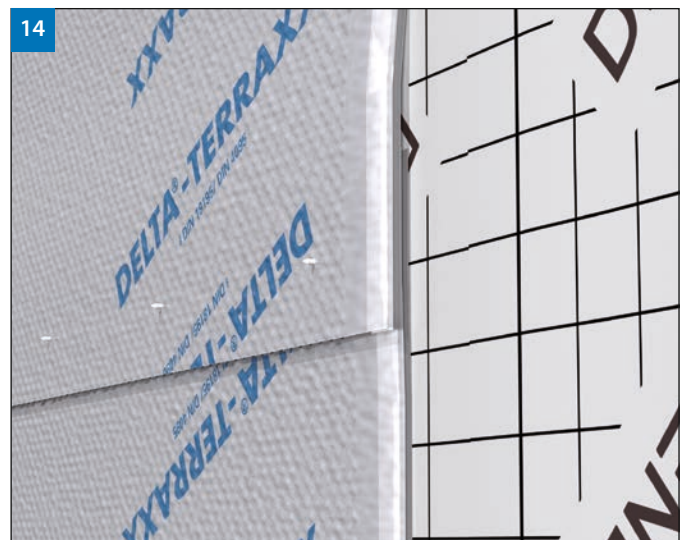
(Bild 14) Beide Teile werden mit mindestens 4 DELTA®-Haftnägeln verbunden.
