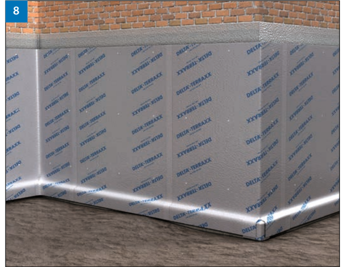
(Bild 8) Die abschließende letzte Bahn sollte am Ende mindestens 30 cm breit mit der Anfangsbahn überlappt werden.
