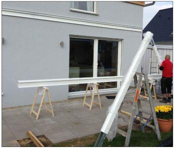
Legen Sie die Rinnenpfette und die mit den Pfostenlaschen versehenen Pfosten zur Montage bereit. Aus statischen Gründen dürfen die beiden äußeren Pfosten seitlich maximal 50cm eingerückt werden!
