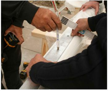
Zeichnen Sie die mit Gewinde vorgebohrten Schraublöcher der einzelnen Pfostenlaschen an die jeweiligen Pfosten an. Bohren Sie mit einem 9mm Metallbohrer vor und schieben Sie die Laschen in den entsprechenden Pfosten. Zeichnen, bohren und verschrauben Sie Lasche für Lasche, da die Bohrlöcher der einzelnen Laschen variieren können!
