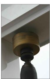
Mit einer Bohrkrone (Durchmesser 68-70mm) bohren Sie jetzt den Anschluß für das Fallrohr. Es kann sowohl neben als auch im Pfosten verbaut werden. Bitte beachten Sie dabei den Versatz in der Rinnenpfette (siehe Detailzeichnung) sowie den Abstand der Clipphalter für das Fallrohr zum Pfosten! (ca. 2cm)
