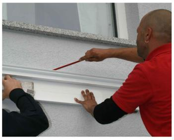
Bohren Sie die Löcher in der Wandpfette (Abstand ca. 40cm) mit einem Metallbohrer vor. Halten Sie die Pfette an die Hauswand und richten sie mit der Wasserwaage aus. Zeichnen Sie danach die Bohrlöcher an und bohren diese entsprechend der Angaben des Dübelherstellers. Montieren Sie die Wandpfette mit dem entsprechenden Befestigungsmaterial (z.B. Injektionsankern M12).
