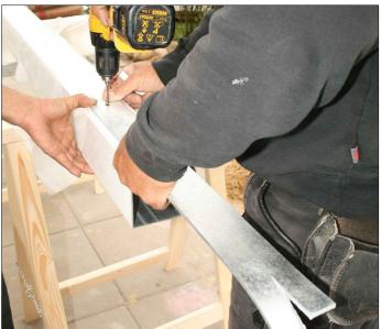
Schrauben Sie die Laschen mit den Maschinengewindeschrauben (C115-020) an.
