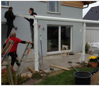
Legen Sie die beiden äußeren Sparren ein und richten Sie diese an der Wand- und an der Rinnenpfette aus.
