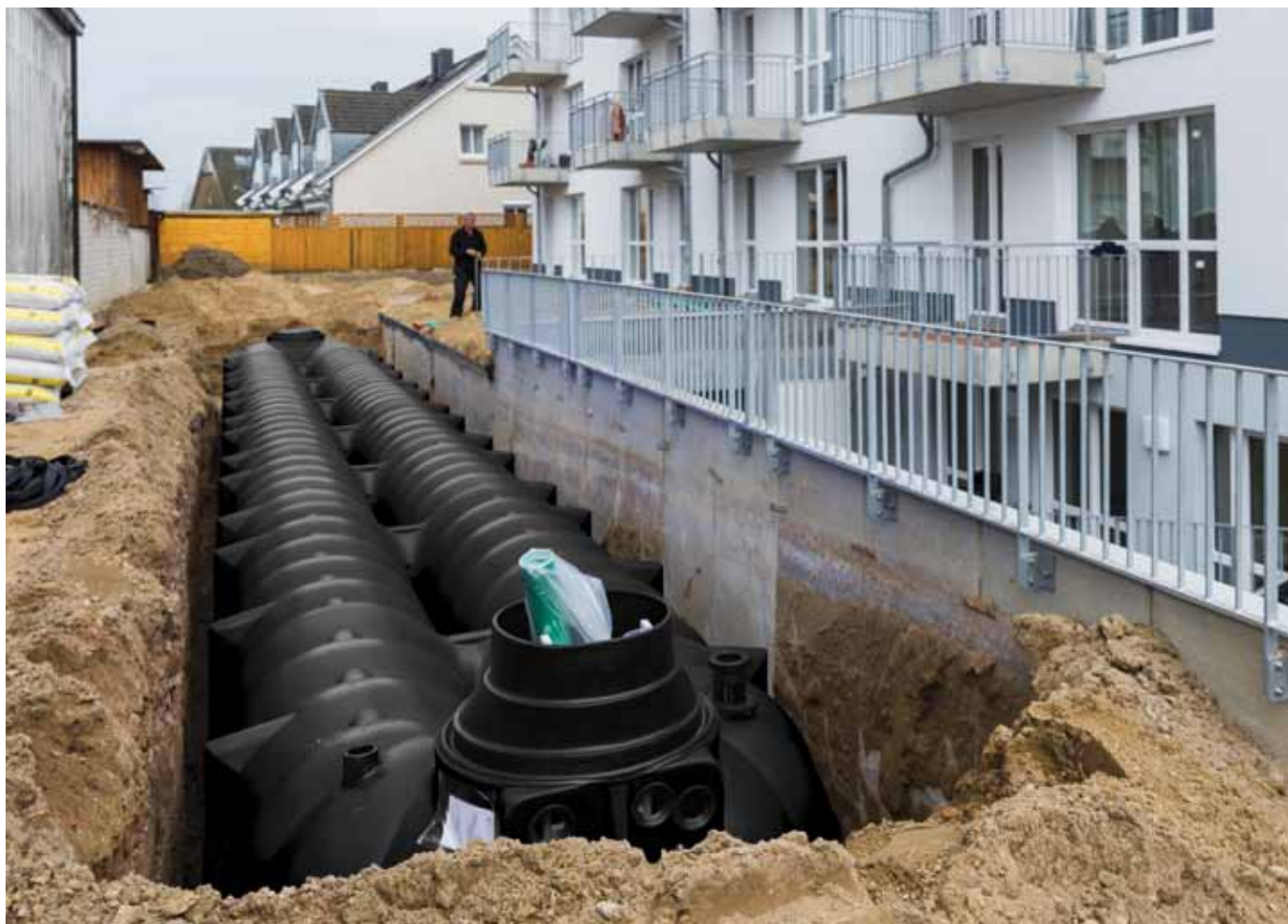
Praxisbeispiel: Einbau NEOplus Löschwassertank 40000 Liter im eng bebauten Wohngebiet
