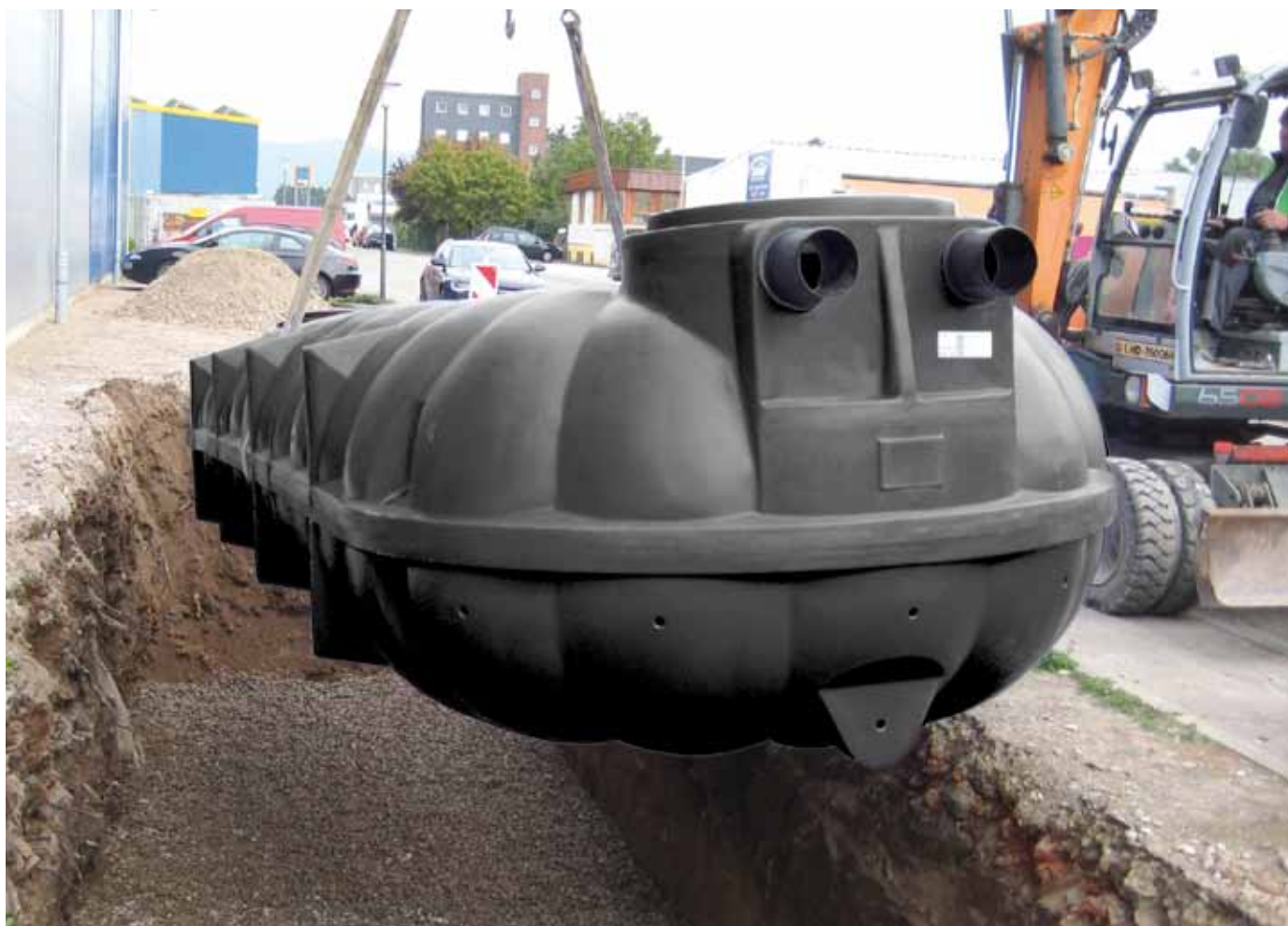
Praxisbeispiel: Einbau einer NEOplus Versickerungsrigole 10.000 Liter
