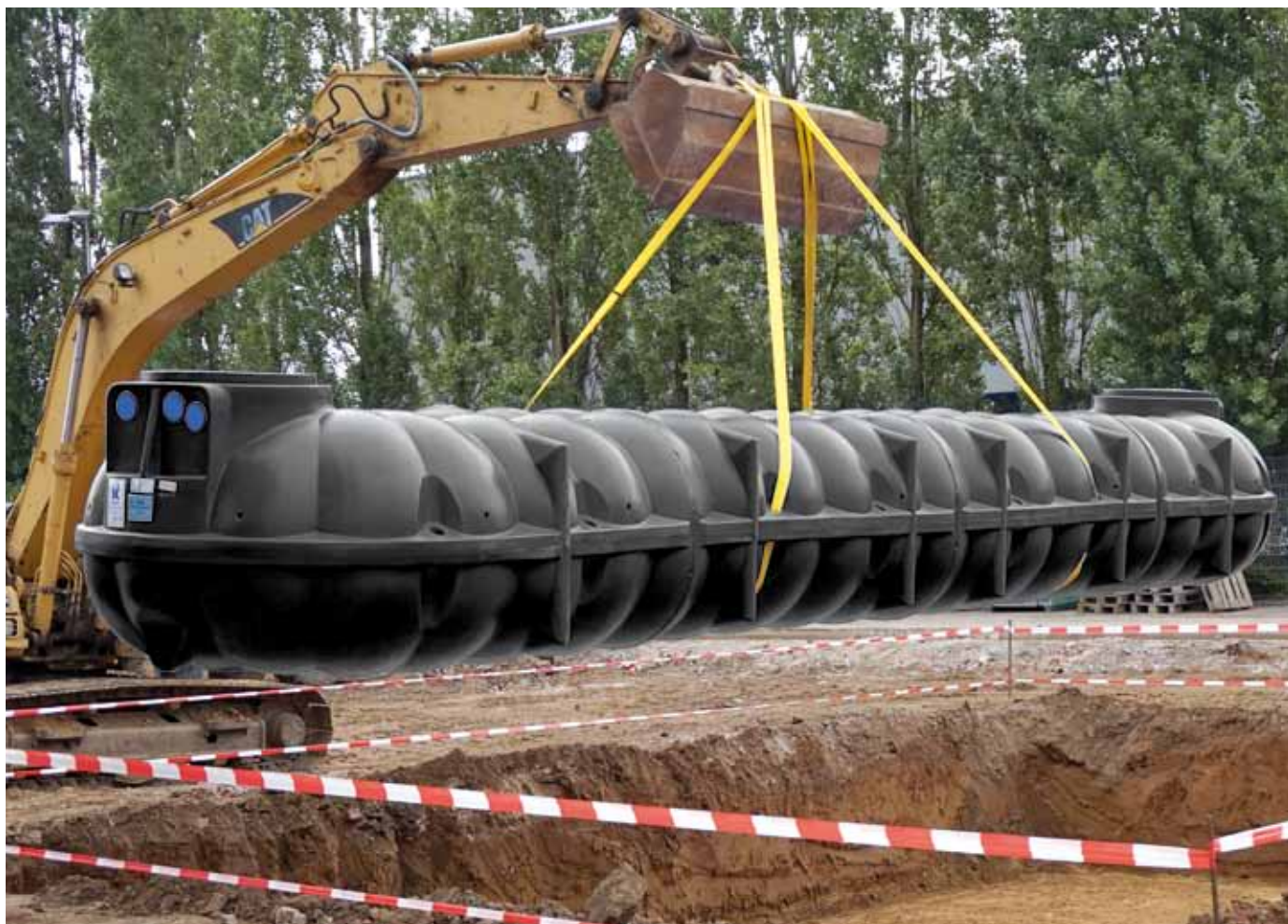
Praxisbeispiel: Einbau NEOplus Sammelgrube 20000 Liter
