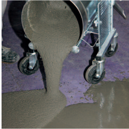
als auch manuell auf die Fläche aufgebracht werden.
