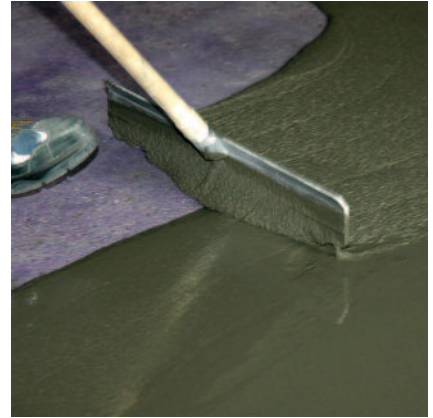
Danach wird PCI Zemtec® 180 mit einer Stiftrassel oder Schwabbelstange verteilt.
