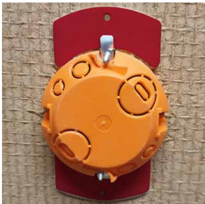
Hohlwanddose montiert, Plattenrückseite
