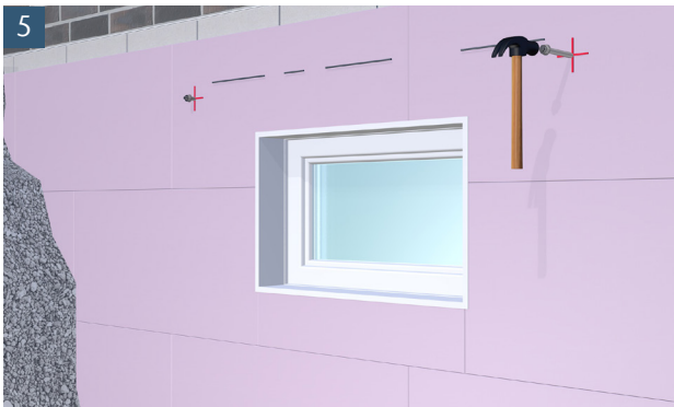
5 Bei Montage direkt an Kellerwand Kunststoffdübel setzen, bei Montage auf Perimeterdämmung Schwerlastanker einschlagen. Schlagen Sie den Schwerlastanker soweit ein, dass max. 30 mm zur Lichtsachtmontage überstehen.
