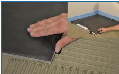
4. Die T-förmigen Zugplatten unter leichtem Druck in das Mörtelbett eindrücken und bis zur Fliesenflanke schieben. Die Platzierung (von mind. 2 Stück pro Fliesenflanke) erfolgt ca. 5 cm von der jeweiligen Fliesenecke.
