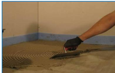
2. Auf den vorbereiteten Untergrund wird der Dünnbettörtel mit der auf die Fliese abgestimmten Zahntraufel aufgekämmt. Bei Großformaten ist auf der Fliesenrückseite eine Kontaktschicht aufzubringen.
