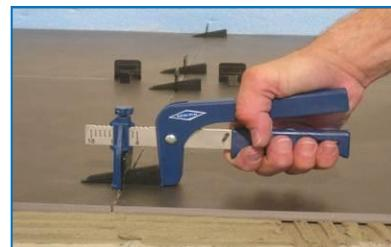
8. Mit der Spannzange wird der Keil in die Aufnahme gedrückt und presst so den Keil an die Zugplatte. Die Fliesenkanten sind auf einer Höhe ausgerichtet.
