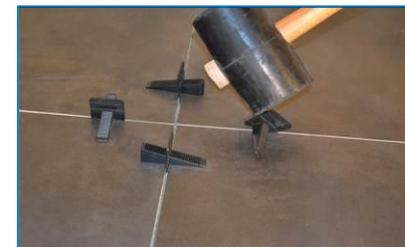
9. Nach Begehbarkeit der Fliesen werden die herausstehenden Zugplatten abgeschlagen. Die Keile können mehrfach verwendet werden. Belag verfügen.
