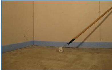
1. Untergründe müssen für die Verlegung der Fliesen geeignet und ausreichend eben sein. An aufsteigenden Bauteilen sind Randdämmstreifen anzubringen. Abgestimmt auf Untergrund und Dünnbettkleber ist nach Bedarf eine Grundierung aufzubringen.
