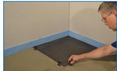
3. Die erste Fliese wird in das frische Mörtelbett eingelegt. Anschließend werden die T-förmigen Zugplatten unter die Fliesenkante geschoben. Die Anzahl ist dem Fliesenformat nach der Tabelle (siehe Gebinde) zu entnehmen.
