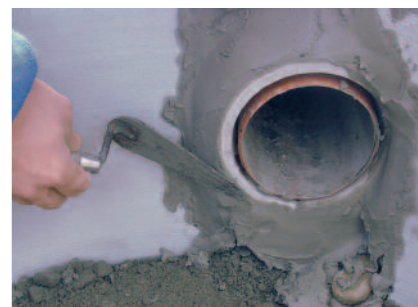
Schachtfutter einmörteln mit PCI Polyfix plus.
