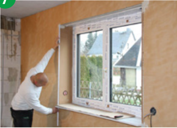
Ausmessen und Aufkleben der Laibungsplatten (20 oder 40 mm)
