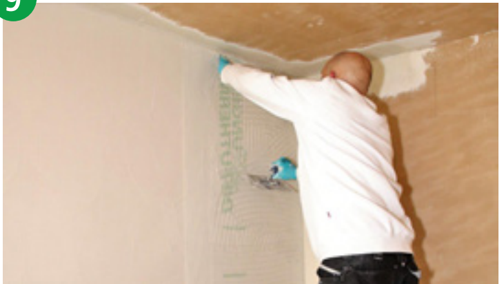
Abschließend wird der UdiGRUNDSPACHTEL® auf die verlegte Dämmfläche aufgezogen und das UdiARMIERUNG® Gewebe für Stabilität eingebettet.
