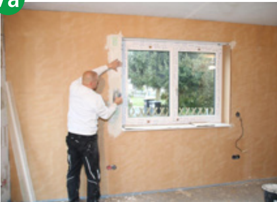
Setzen und Einspachteln der Eckschutzleisten
