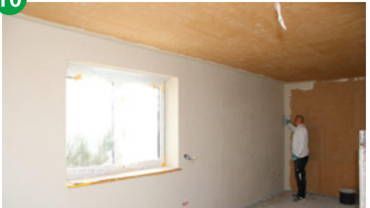
Die Wände glatt spachteln mit dem UdiKALKFEINPUTZ , ggf. weitere Beschichtung nach Kundenwunsch möglich.
