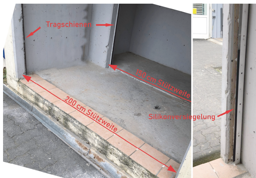
Abbildung 3.1: Lage der Tragschienen bzw. Bodenbeschaffenheit im Versuchsgebäude
