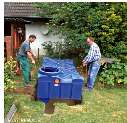
Foto: REWATEC Einbau einer Kunststoffzisterne.
