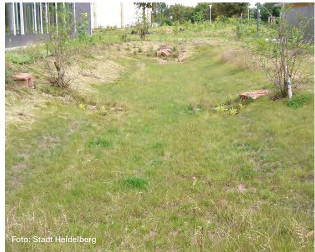
Foto: Stadt Heidelberg Fertiggestellte Versickerungsmulde samt Einläufen.
