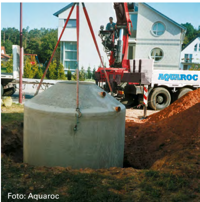
Foto: Aquaroc Einbau einer Betonzisterne.
