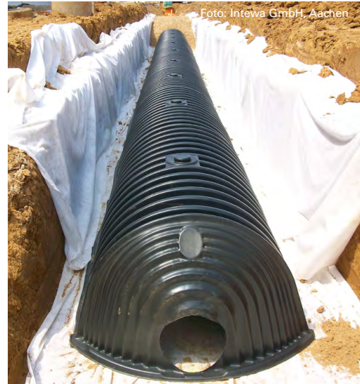
Regenwasserversickerung mit Tunnelementen.
