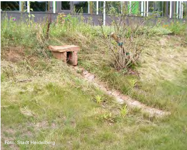
Foto: Stadt Heidelberg Die Regenwasserableitung führt vom begrünten Dach direkt in eine Versickerungsmulde.
