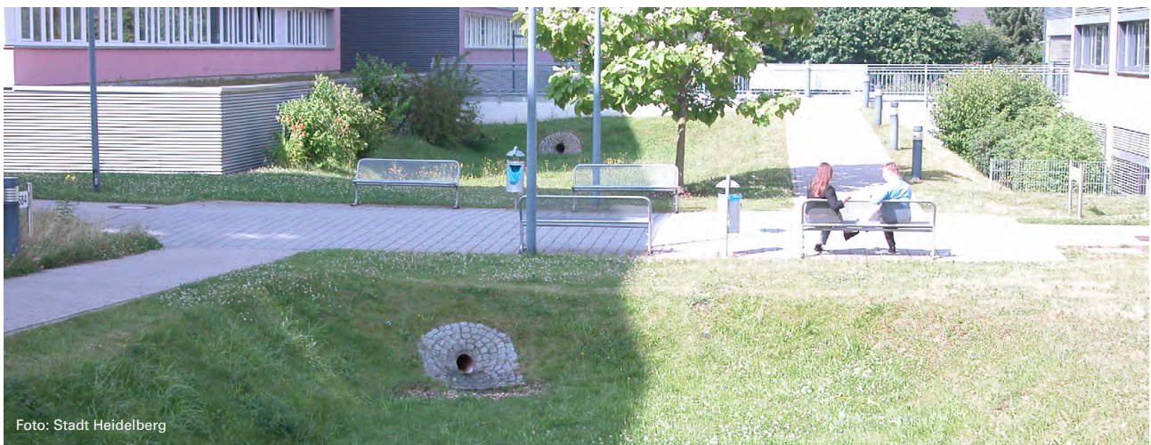
Muldenversickerung Heidelberg Technologiepark.
