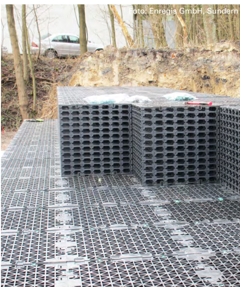
Aufbau einer Regenwasser-versickerungsanlage.
